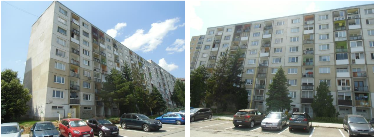
Obr. 3 Pohľad na existujúci susedný bytový dom Wuppertálska č.5,7,9,11
