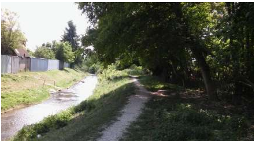
Pohľad na potok IDA od severu, vpravo oplotenie areálu kaštieľa
