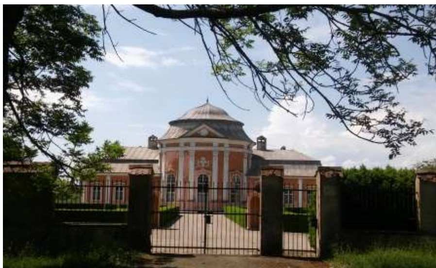
Kaštieľ Šemšeyovcov, pohľad od východu
