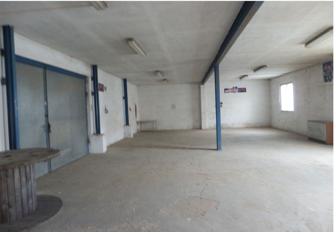
Interiér časti nového objektu
