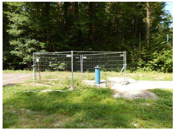
Zrealizovaný geotermálny vrt v Púšti
