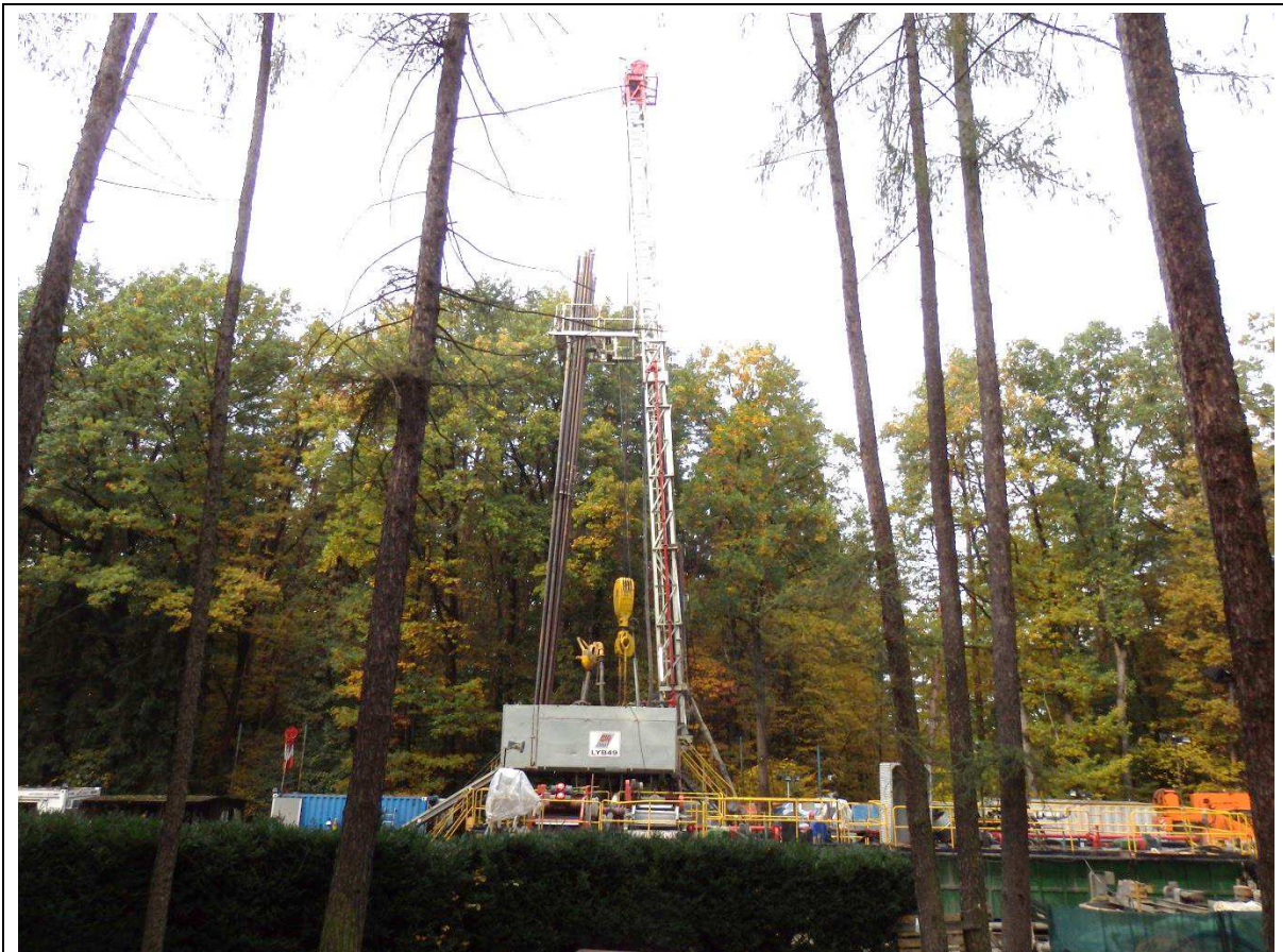
Obrázok 23: Príklad pracovnej plochy pri zhotovení geotermálneho vrtu v Púšti
