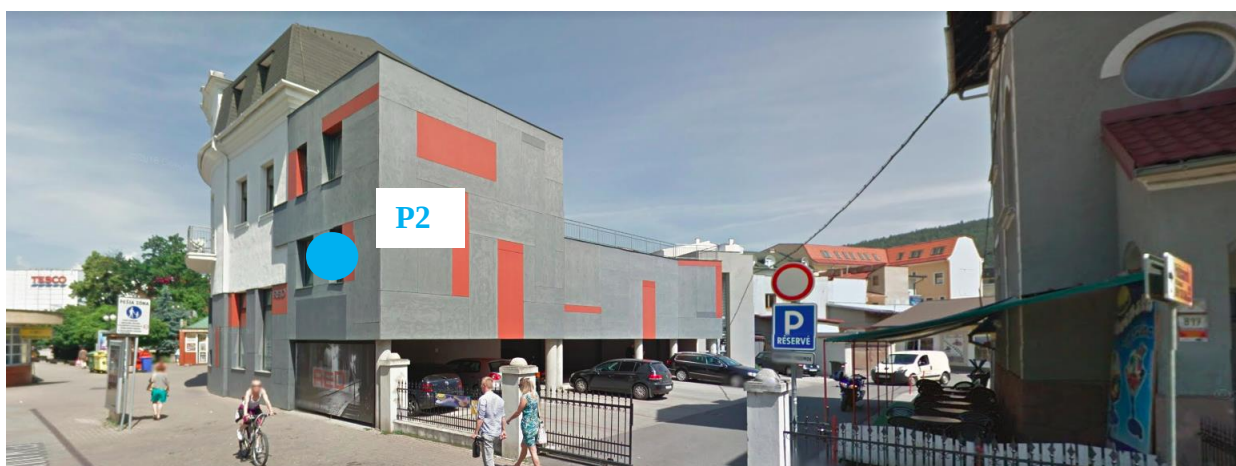
Obr.10 Posudzovaná budova na parc. č. 1815 s vyznačením kritického kontrolného bodu P_2
