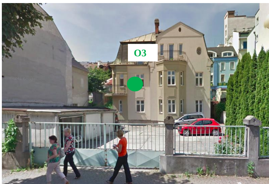
Obr.13 Posudzovaná budova na parc. č. 1831 s vyznačením kritického kontrolného bodu O_3
