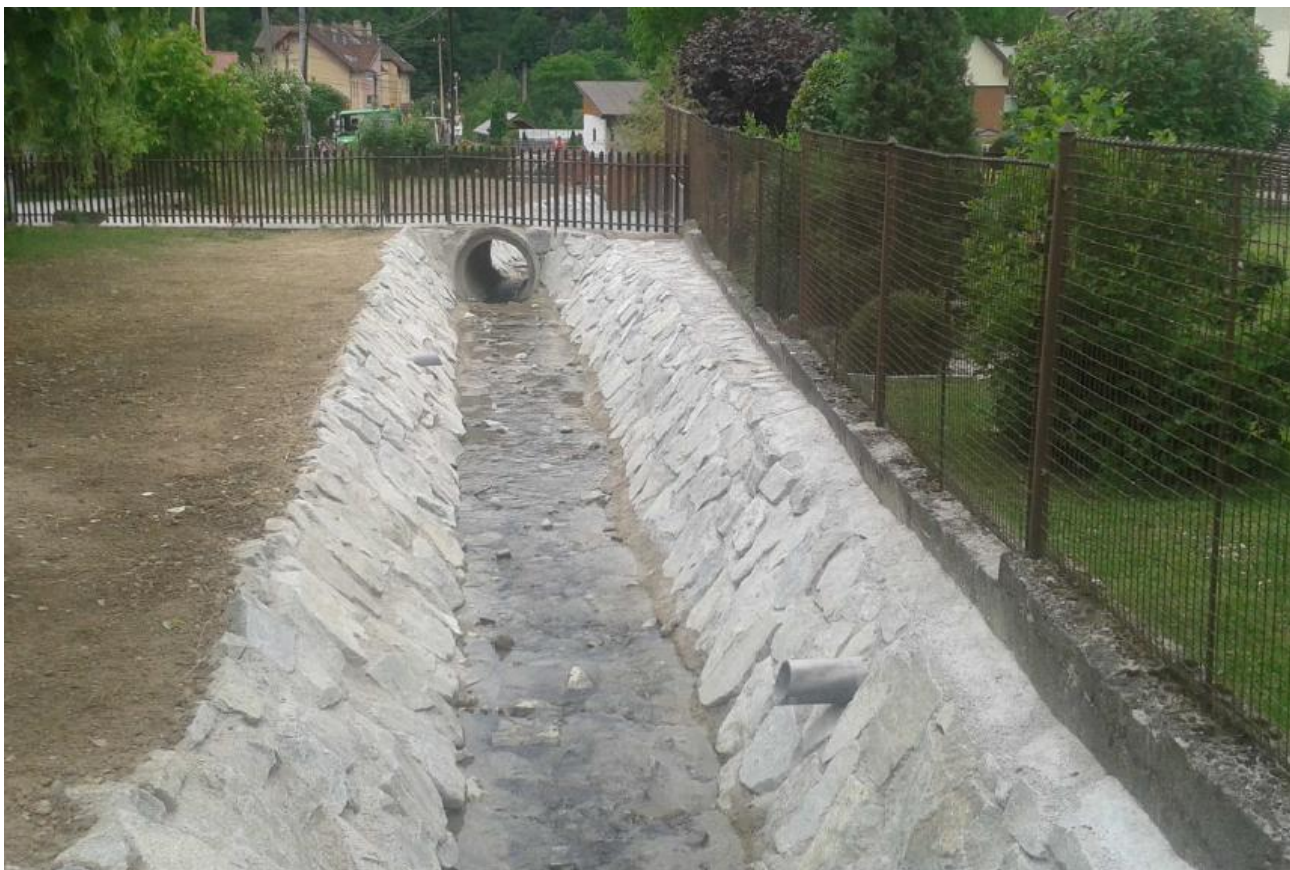
Obr.1 Úprava svahov rovnanina z lomového kameňa s vyškárovaním
