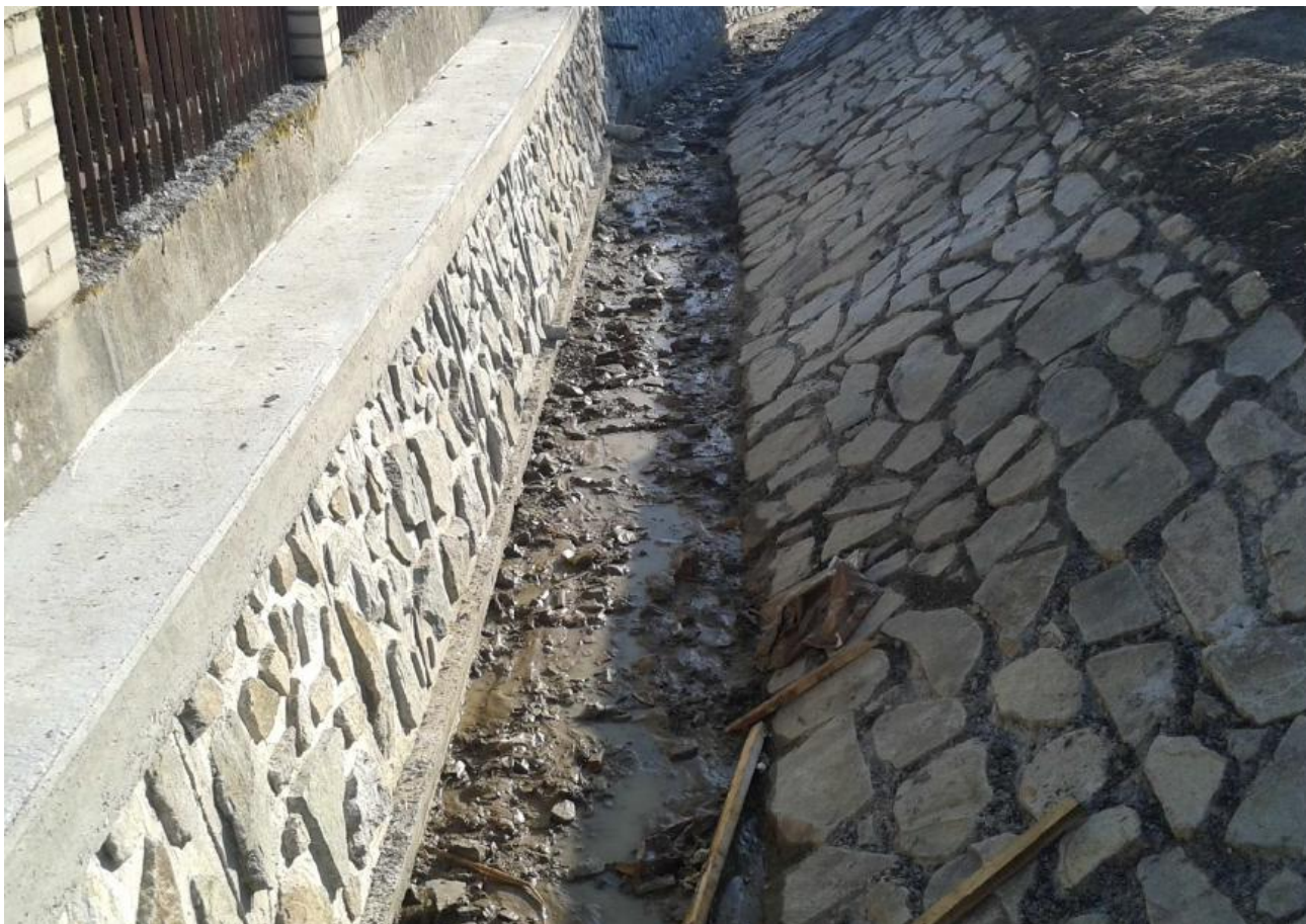
Obr.3 Kombinácia úpravy, oporným múrom, dlažba z lomového kameňa
