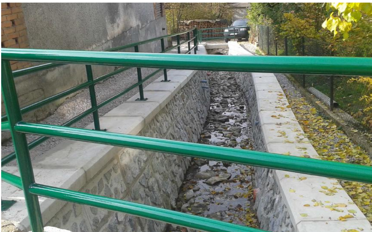
Obr.2 Úprava oporným múrom so zábradlím na rímse
