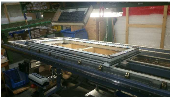
Obr. 12 Osadenie bezpečnostného kovania na ráme okna
