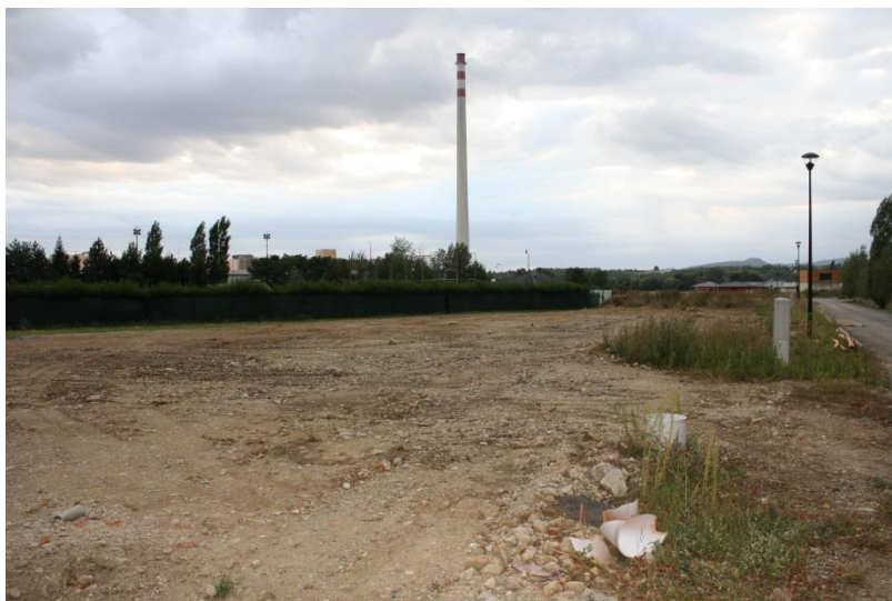
Pohľad zo západu na predmetnú lokalitu umiestnenia SO 01 Bytový dom I.
