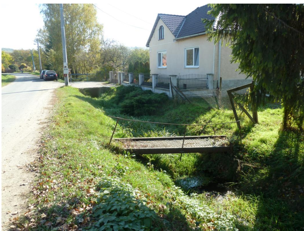
NEUPRAVENÉ KORYTO POTOKA
