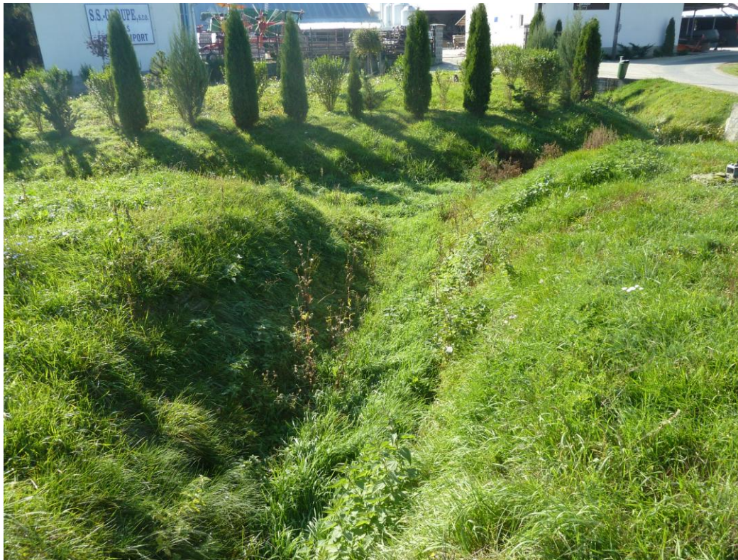
NEUPRAVENÉ KORYTO POTOKA
