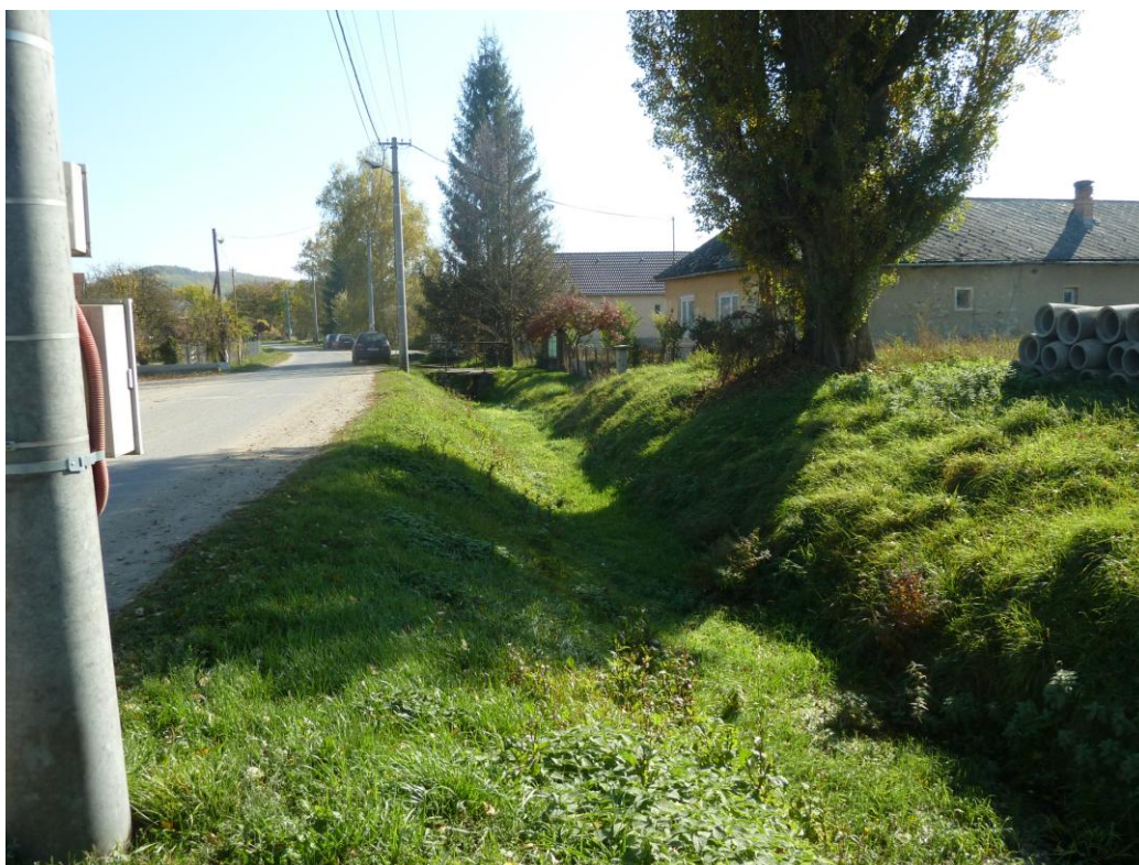
NEUPRAVENÉ KORYTO POTOKA
