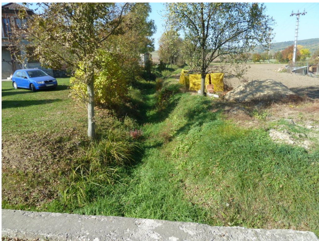
NEUPRAVENÉ KORYTO POTOKA
