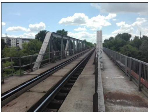
Obr. (1) Súčasná konštrukcia mosta – prvková mostovka – drevená mostnica (podvaly) sú umiestnené priamo na oceľovom priečniku
