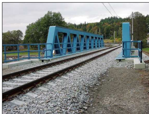
Obr. (1) Súčasná konštrukcia mosta – prvková mostovka – drevená mostnica (podvaly) sú umiestnené priamo na oceľovom priečniku
