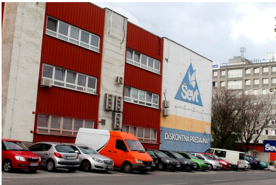
Obr. 3 Budova bývalých Bratislavských tlačiarňí, pohľad z Plynárenskej ul.
