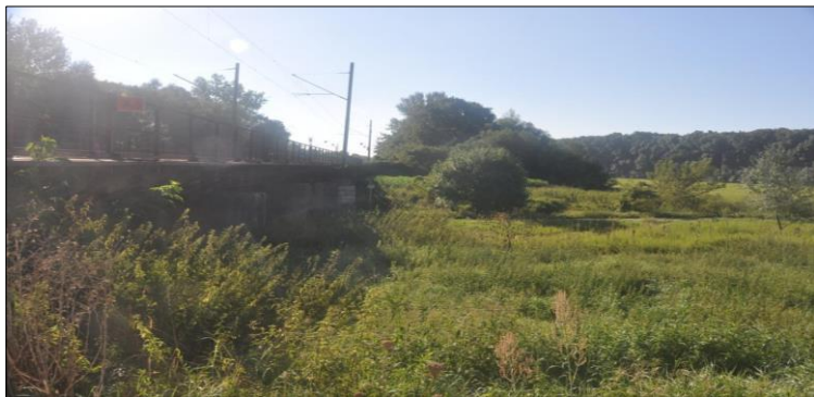
Obr. 8: Úsek križovania železničnej trate s CHVÚ v žkm 73,20 – 74,41, Bordský kanál
