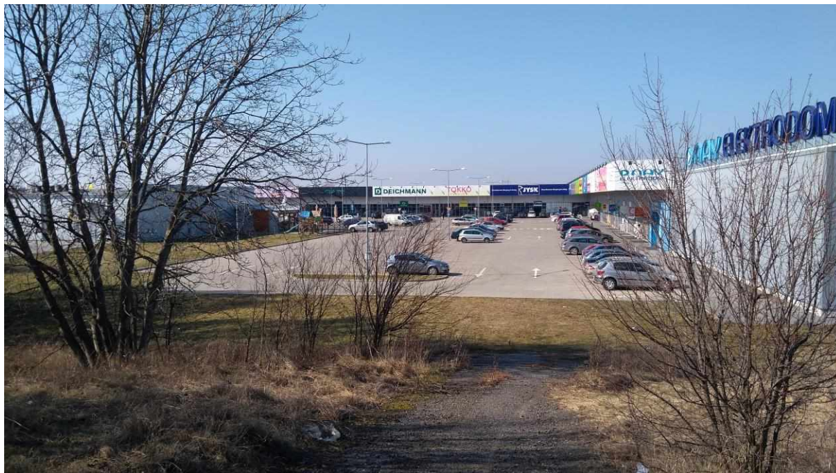
Foto 1 pohľad na areál OC od cesty I/51
