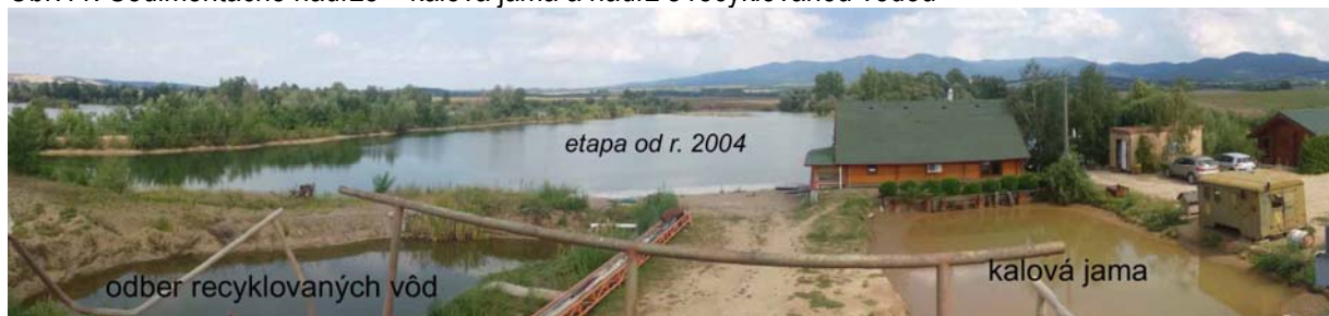
Obr.11: Sedimentačné nádrže – kalová jama a nádrž s recyklovanou vodou
