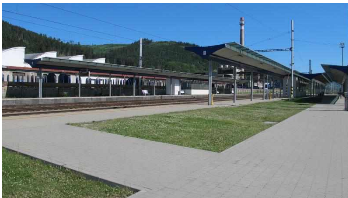
Celkový pohľad na nástupištia železničnej stanice Kysucké Nové Mesto
