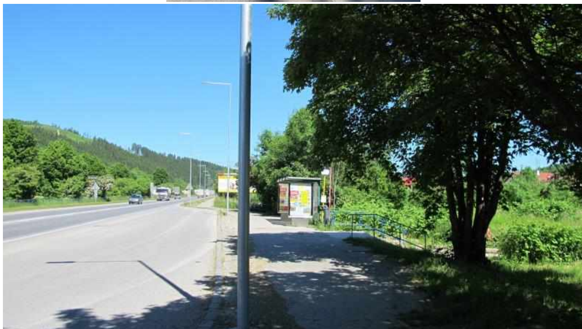
Celkový pohľad na autobusovú zastávku Čadca
