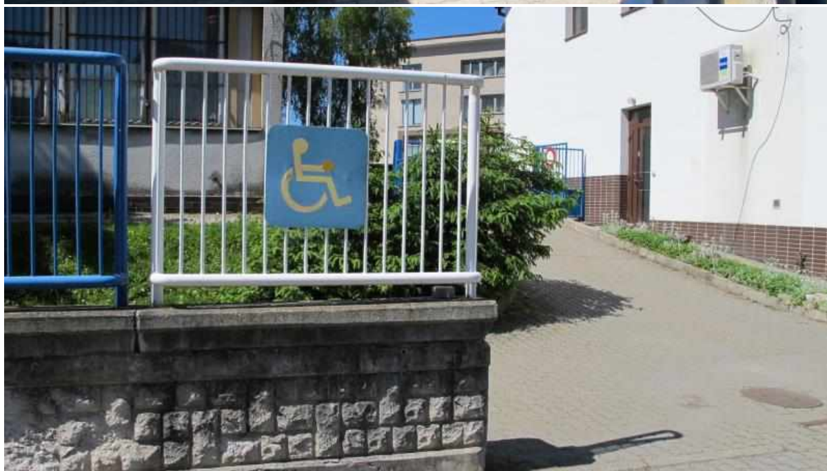
Celkový pohľad na exteriér a interiér železničnej stanice Čadca (prístup pre osoby s obmedzenou schopnosťou pohybu na prvé nástupište)
