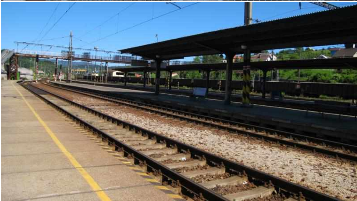
Celkový pohľad na exteriér a interiér železničnej stanice Čadca
