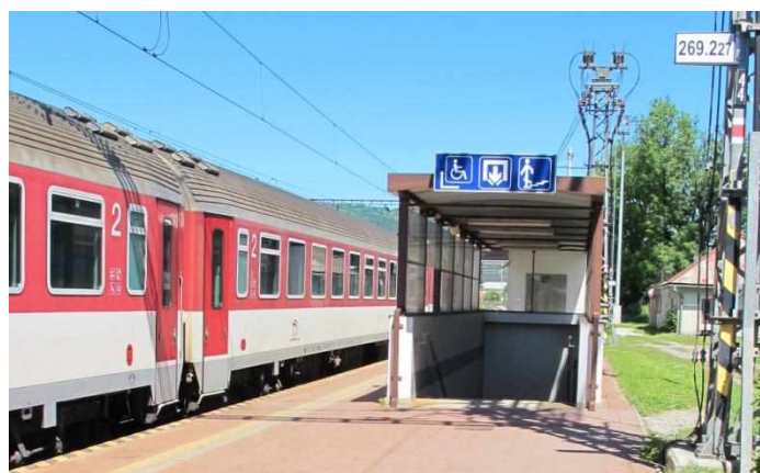
Celkový pohľad na nástupištia železničnej stanice Krásno nad Kysucou
