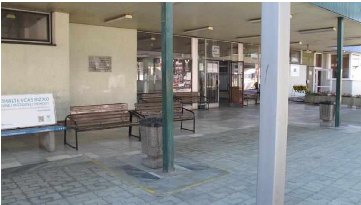
Pohľad na prvé nástupište železničnej stanice Kysucké Nové Mesto
