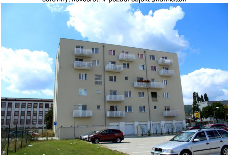
Obr. 6 Bytový dom Cornville, parkovisko objektu obchodnej prevádzky Billa, vľavo hranice pozemku určeného na výstavbu navrhovanej činnosti a v pozadí objekt Výskumného ústavu zväračského
