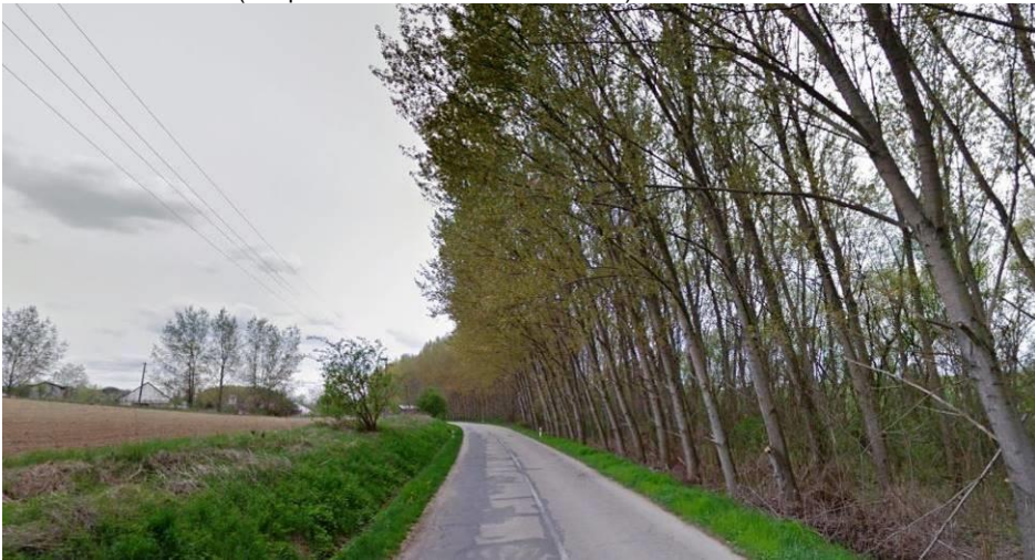
obr. 59 Cesta III/1674 (vstup do katastra obce od Rišňovca)
