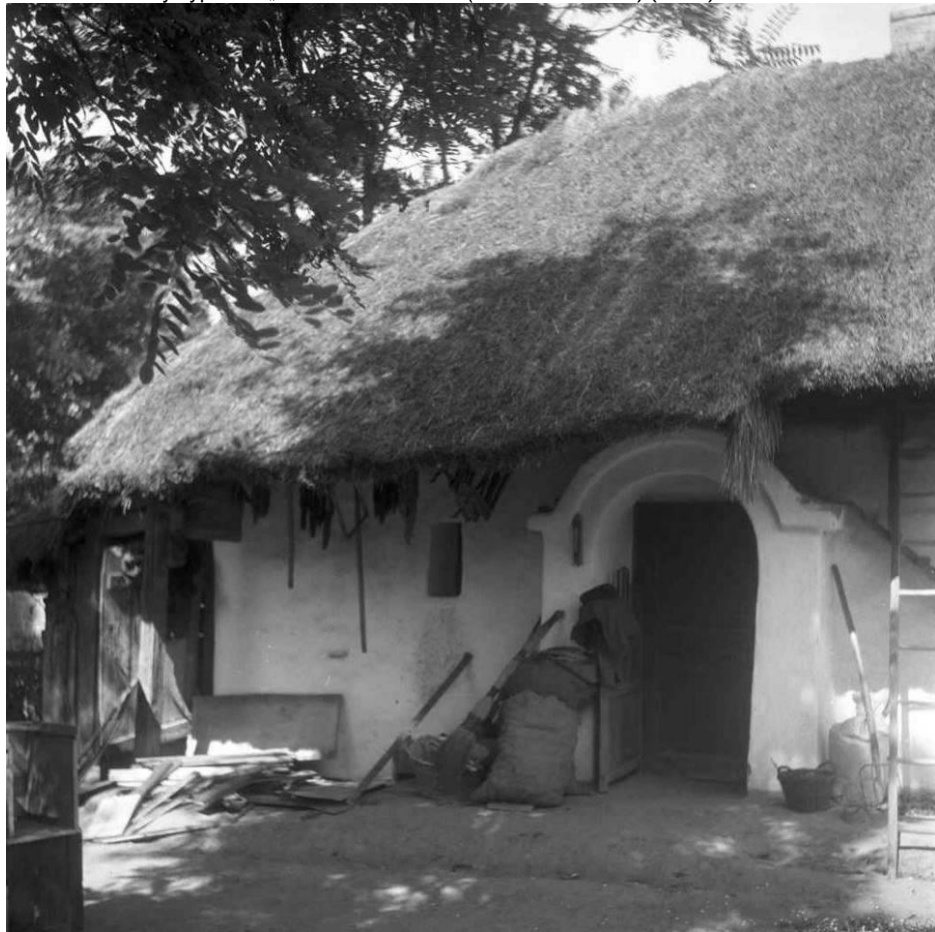
obr. 37 Murovaný výpusok „Pilír“ v dome č. 235 (fotka z roku 1962) (lit. 89)
