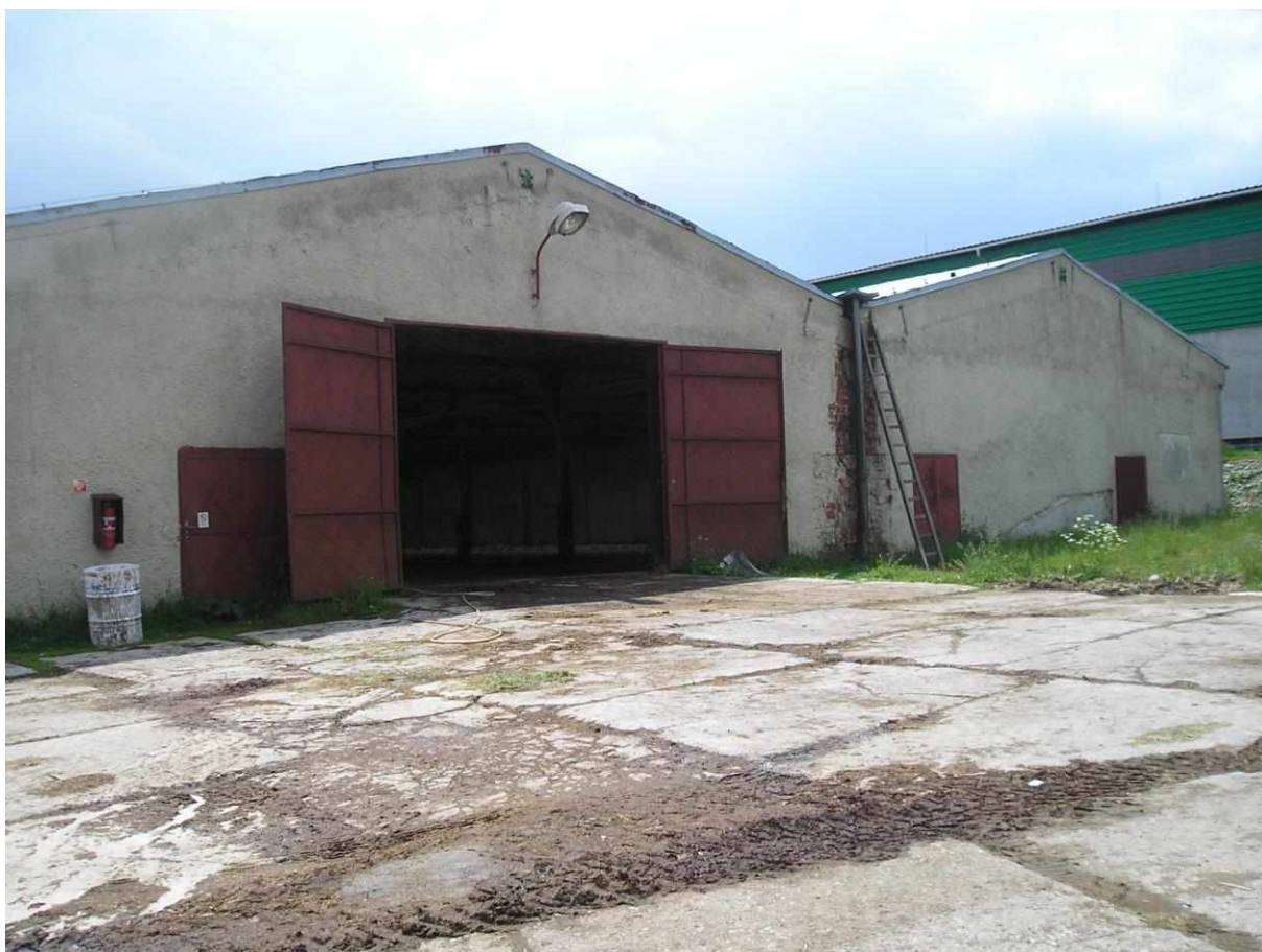
Obr. č. 2 Maštal', ktorá sa bude rekonštruovať
