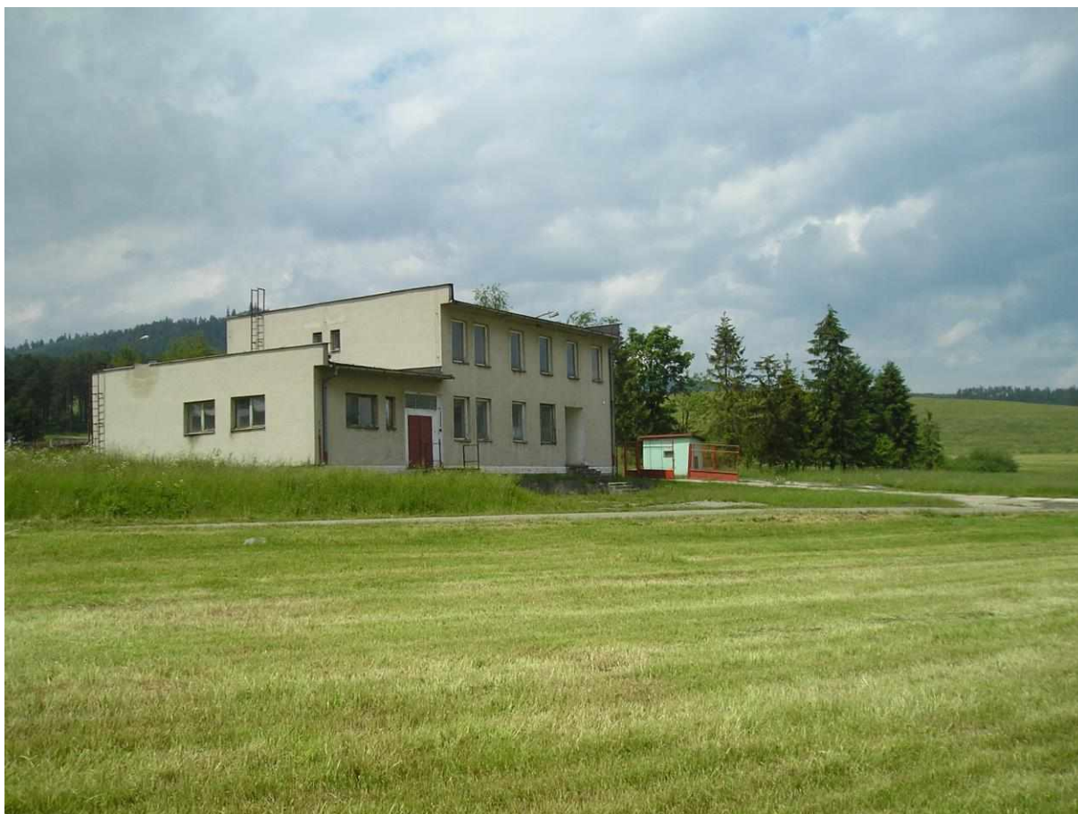
Obr. č. 1 Záujmové územie (vstup do areálu poľnohospodárskeho dvora)
