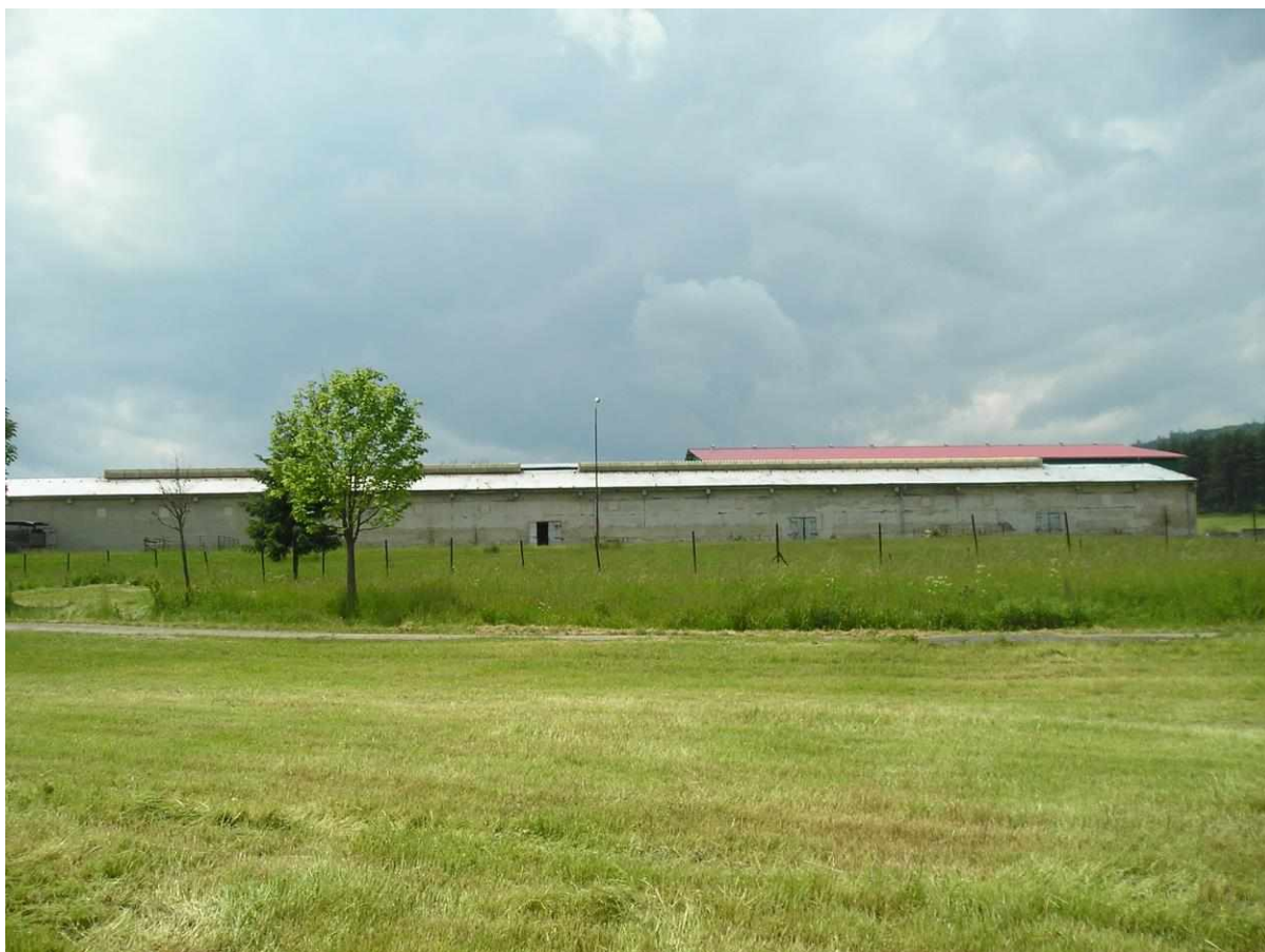
Obr. č. 3 Zaujmové územie (bočný pohľad na dotknutý objekt)
