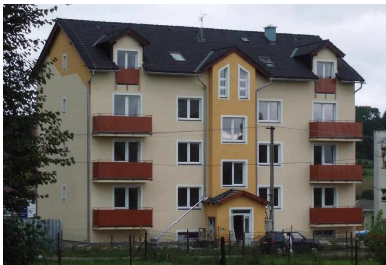
Obr. 12 Nájomný bytový dom
