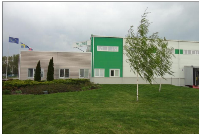
Obr.6: Pohľad na plochu budúceho rozšírenia administratívnej časti firmy
