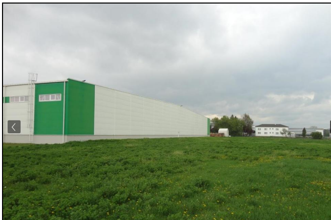
Obr.5: Pohľad na plochu budúceho rozšírenia výrobnjej haly firmy Camfil s.r.o.
