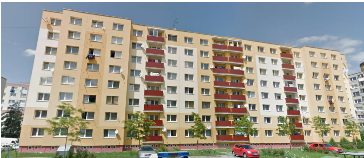
Obr. 79 Riešený bytový dom ul. Polomská 1781
