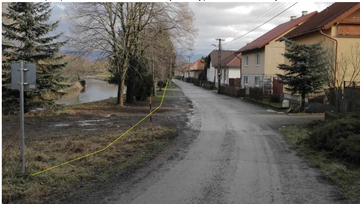
Obr.3: Lína protipovodňového múrika SO1 v západnej polovici ulice Pod hájom
