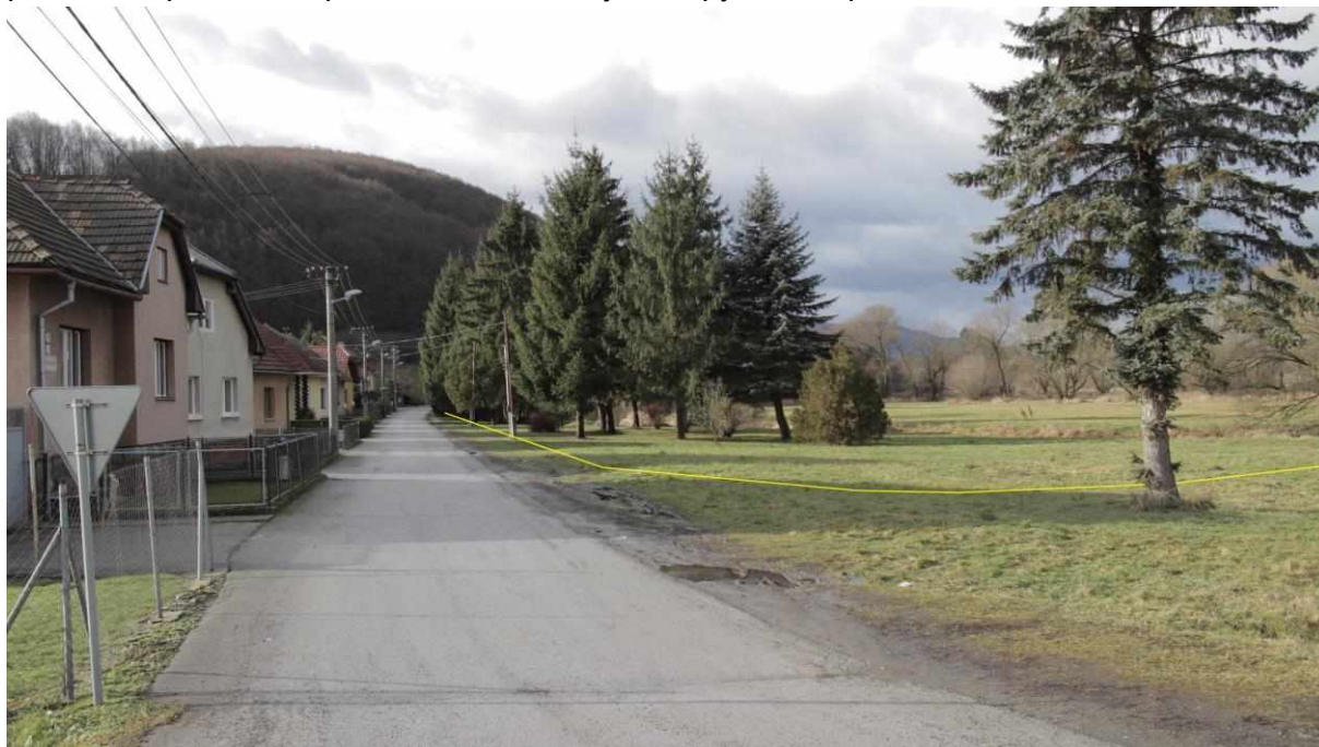
Obr.2: Lína protipovodňového múrika SO1 vo východnej polovici ulice Pod hájom
