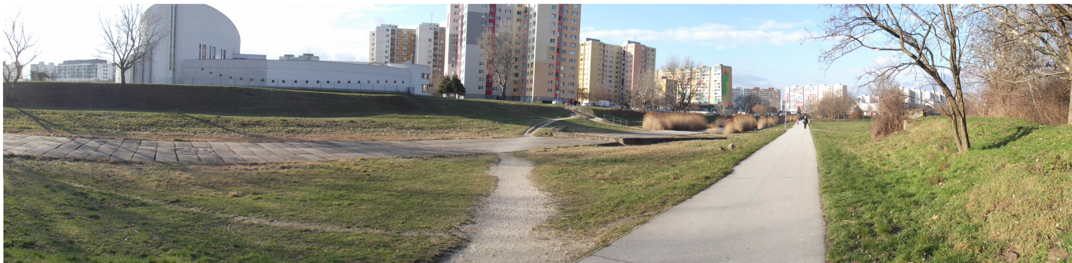
Obr. č. 1: Pohľad na polohu umiestnenia navrhovaného električkového mosta v km 3,7 - 3,8 nad korytom Chorvátskeho ramena
