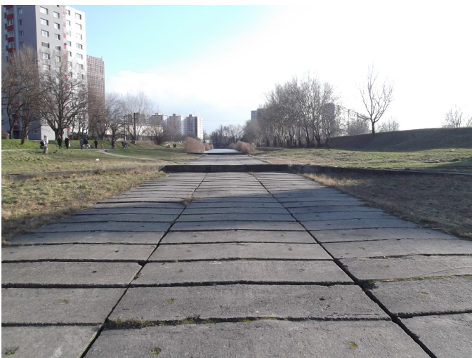
Obr. č.2: Koryto Chorvátskeho ramena prekryté panelmi v km 3,73 (pozostatok pôvodnej plánovanej trasy metra)
