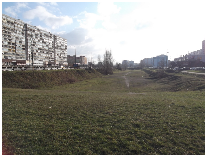
Obr. č.2: Pohľad na úsek stavby v km 4,1 - 4,4, vľavo trasa existujúcej Jantárovej cesty
