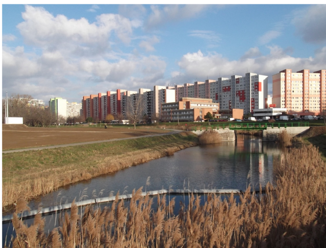
Obr. č.3: Pohľad na Chorvátske rameno v km 2,5 trasy stavby (úsek navrhovanej úpravy ramena)
