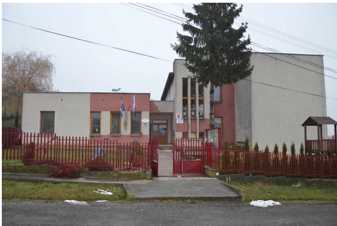
Obrázok č.3 Budova OčÚ a Materskej školy v obci Proč
