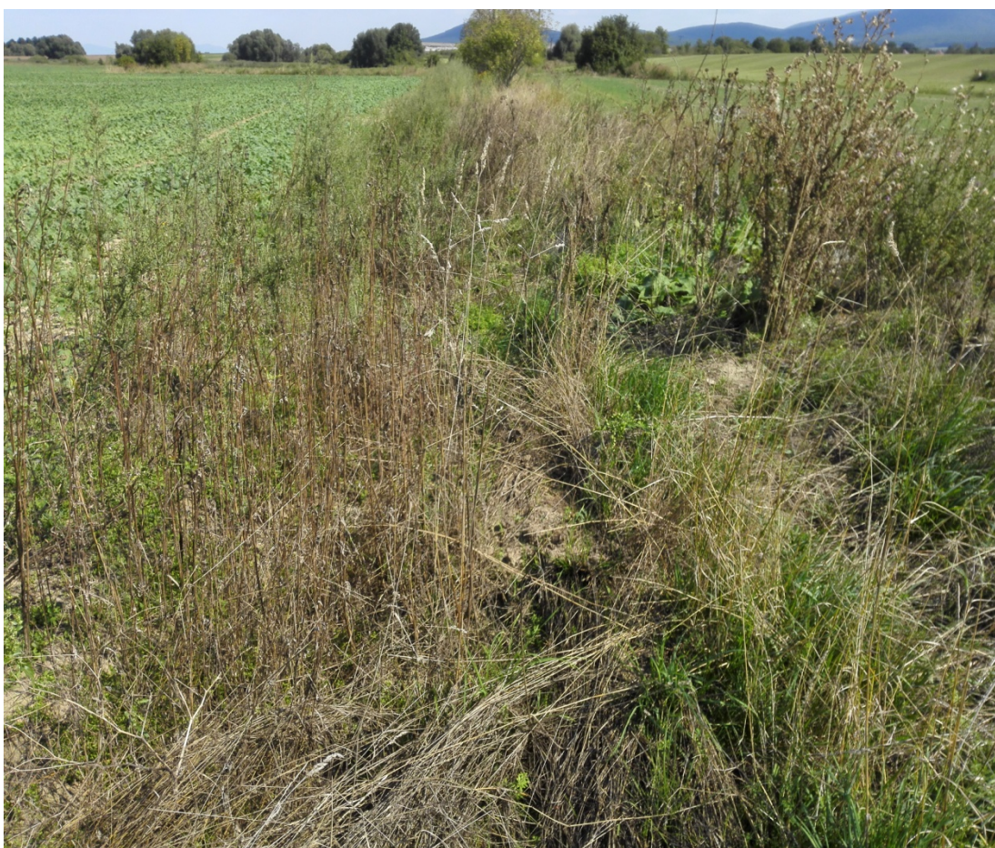
Obr. X.2. Kanál (ev. č. 5209 091 007) v obci Oponice.
