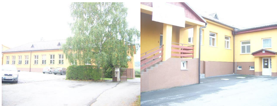
Obr. 10 Pohľad na budovu ZŠ a MŠ
