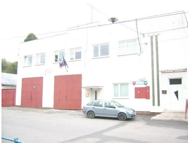
Obr. 11 Budova obecného úradu a hasičskej zbrojnice v obci Hrabkov
