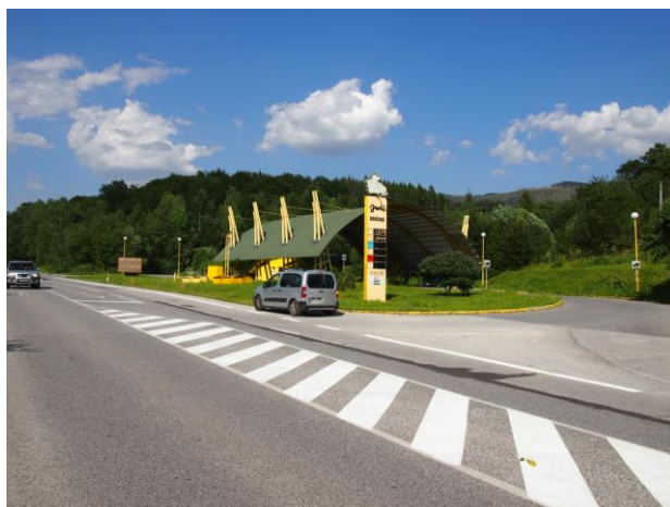
Obr. 7 Čerpacia stanica pohonných hmôt Dobšiná
