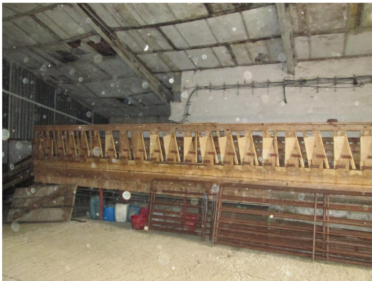
Obr.č.1 - ovčín a dojáreň – súčasný stav
