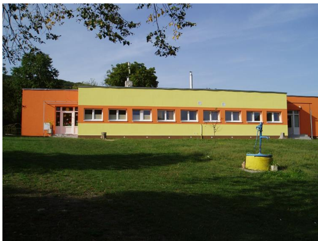
Obr. 9 Zrekonštruovaná MŠ s Ocú v obci Remeniny
