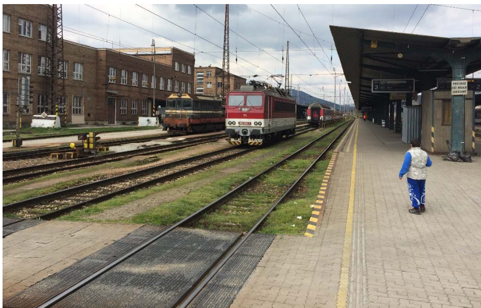
Obr. 2.13 Pohľad na nástupište č. 2 od košického zhlavia
