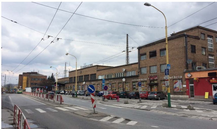
Obr. 2.26 Výpravná budova v pohľade z ulice P. O. Hviezdoslava
