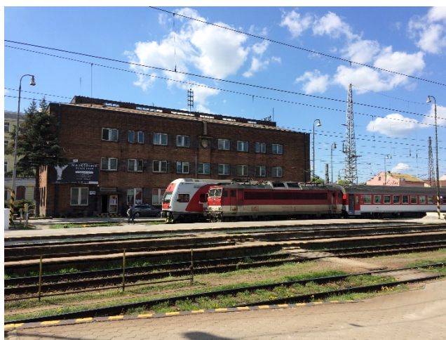
Obr. 2.21 Pohľad na prístup k nástupišťam č. 4 až č. 7
