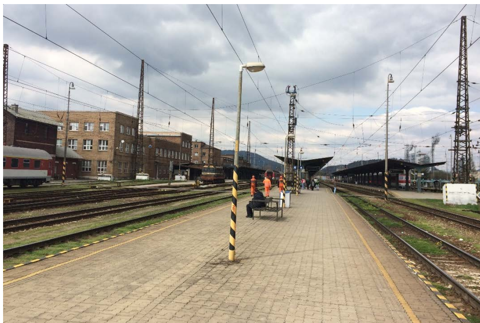
Obr. 2.14 Celkový pohľad na nástupištia č. 1 (vľavo), nástupište č. 2 (v strede) a nástupište č. 3 (vpravo) od košického zhlavia
