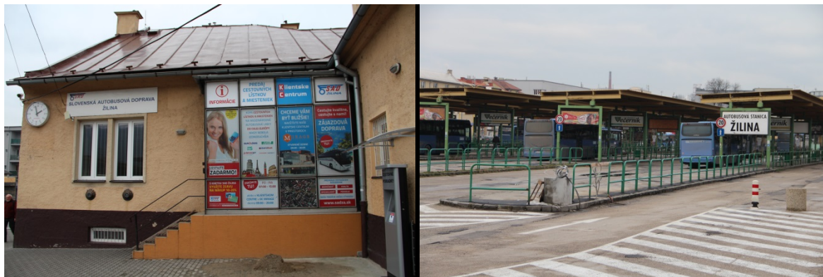
Obr. 6.26 Zastaraná tzv. výpravná budova (vpravo) a priestory Autobusovej stanice Žilina
