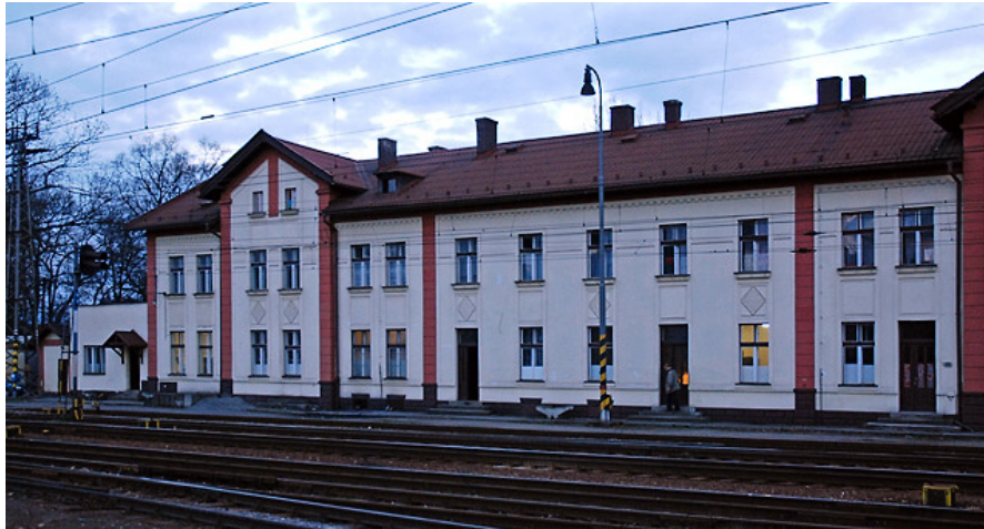
Obr. 2.31 Administratívna budova ŽST Žilina-zr. st.
