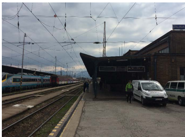
Obr. 2.19 Pohľad na prístup ku koľajam č. 5 a č. 9 z nástupišťa č. 1
