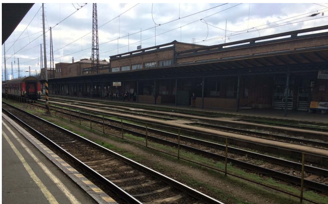
Obr. 2.12 Pohľad na nástupište č. 1 nachádzajúcim sa pred výpravnou budovou z nástupišťa č. 2
