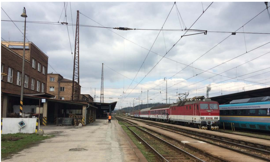
Obr. 2.11 Pohľad na nástupište č. 1 nachádzajúcim sa pred výpravnou budovou od košického zhlavia
