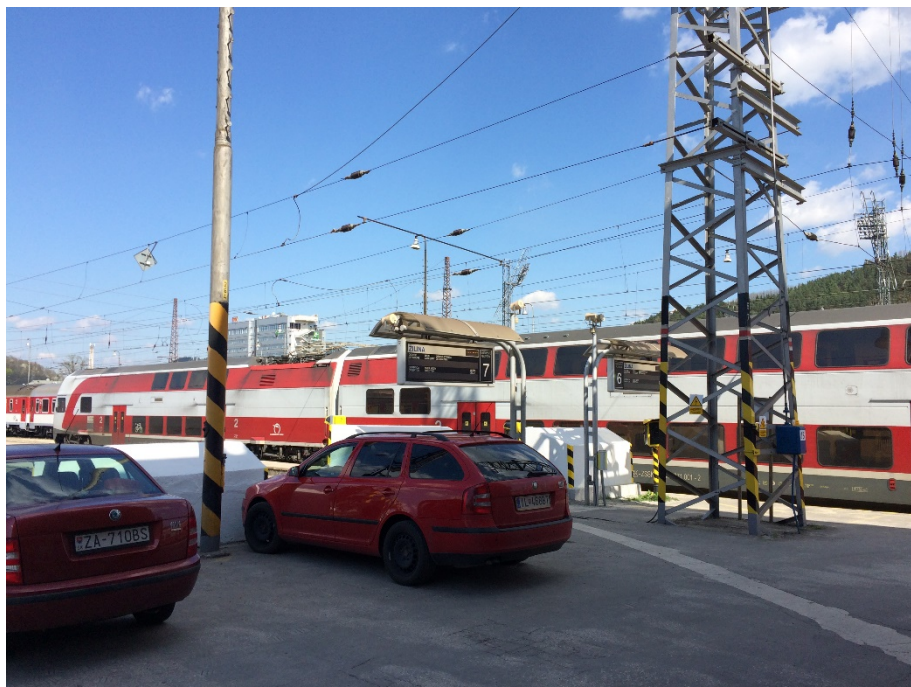
Obr. 2.16 Pohľad na nástupište č. 6 a 7 od boku administratívnej budovy
