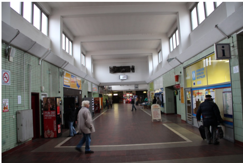
Obr. 6.22 Zastaraný interiér železničnej stanice Žilina
