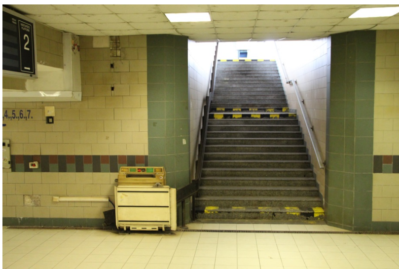
Obr. 6.23 Nefunkčné zariadenia pre ŤZP pre prístup na nástupištia železničnej stanice
