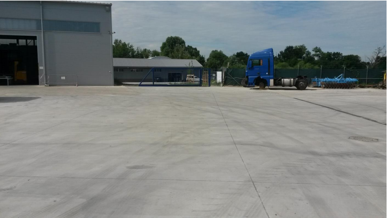
Plocha určená na skladovanie vozidiel pred spracovaním.
