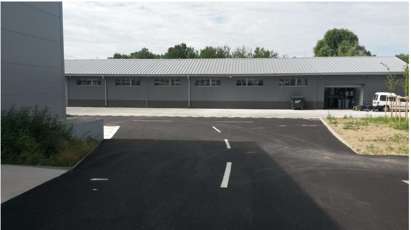
Objekt určený na spracovanie vozidiel, dielňa a administratívna budova
