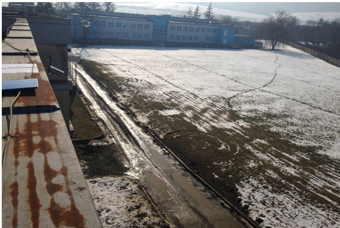
Pohľad z východnej strany
