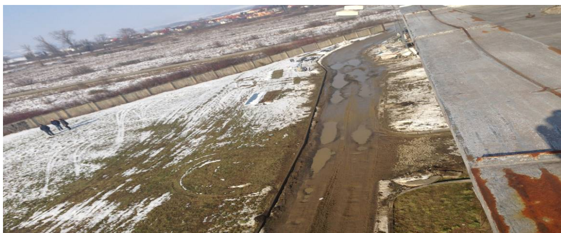
Pohľad od existujúcich budov ŽP
