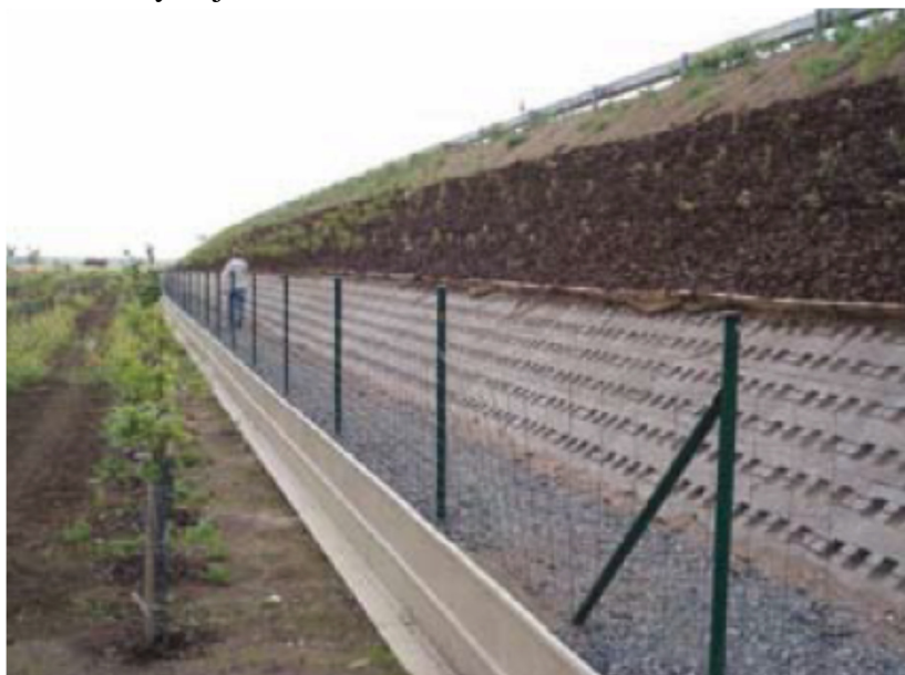
Obrázok 13 Príklad prevedenia zvodidlovej steny v kombinácii s oplatením (katalóg ACO pro, 2007)
