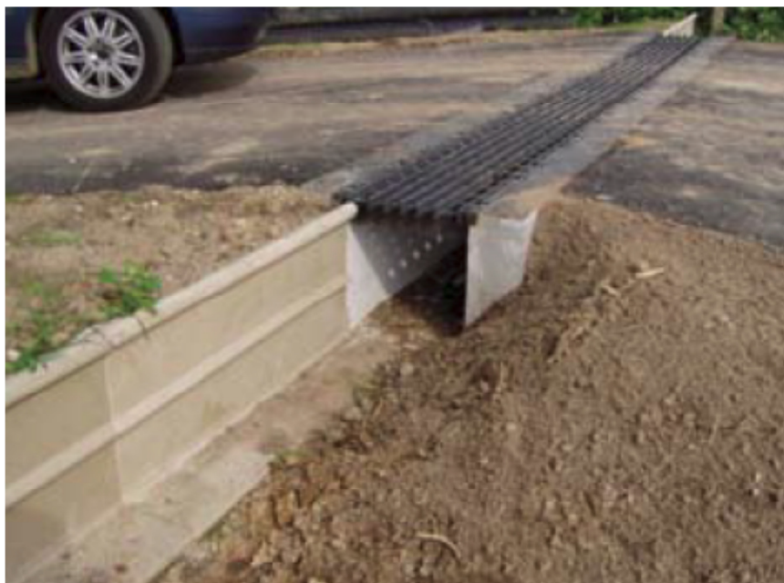
Obrázok 15 Príklad napojenia zvodidlovej steny na cestný podchod
