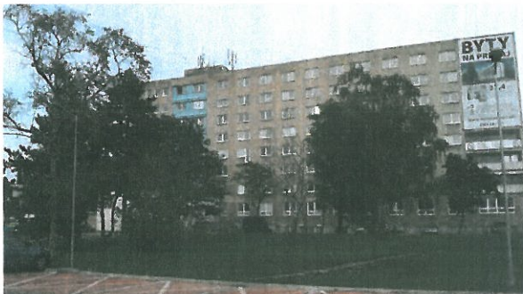
Obr. 4 pohľad na susedný bytový dom
