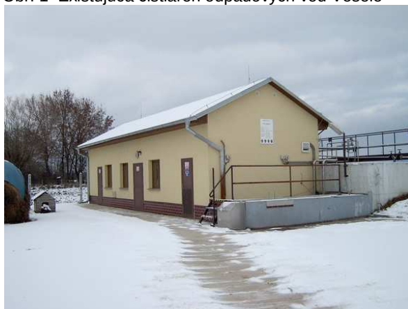
Obr. 1 Existujúca čistiareň odpadových vôd Veselé
