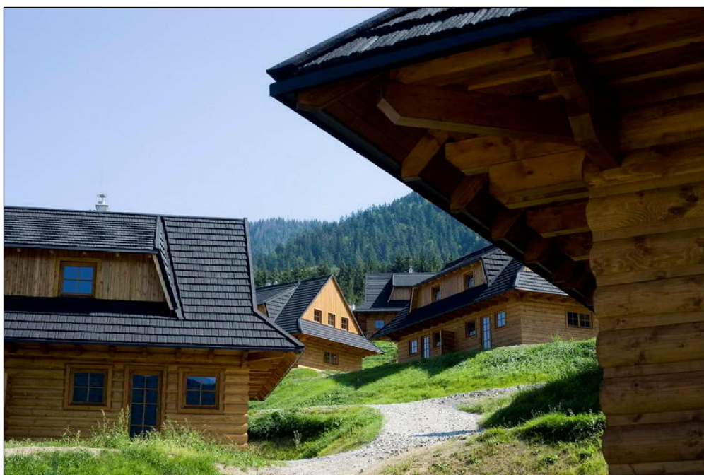
Existujúci rekreačný areál Vršky – pohľad do vnútra areálu.
