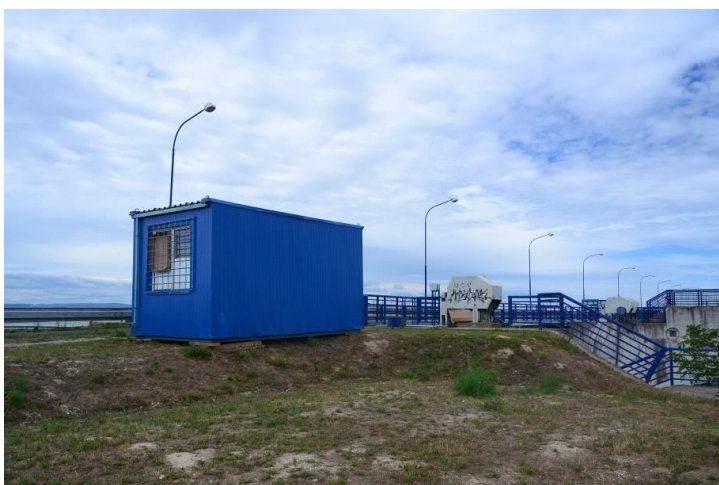
Obr. č. 6 Okolie plocha, kde bude realizovaná rekonštrukcia haťového poľa č. 20
