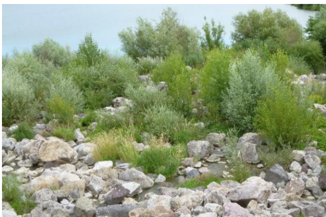
Obr. č. 5 Vegetácia v kamennej navážke pod haťovým poľom č. 20
