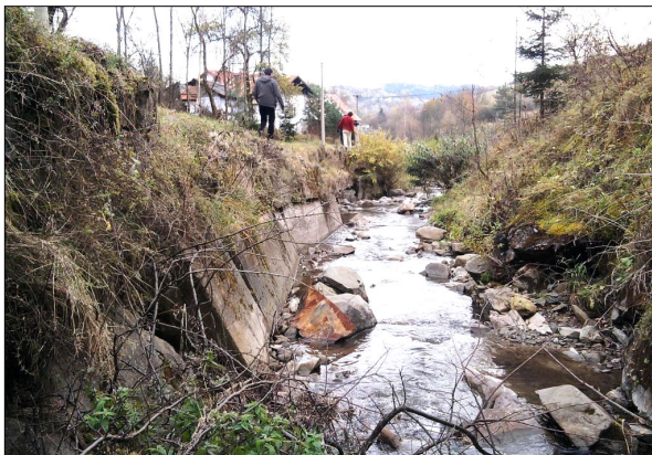
Obrázky č. 7 - 8: Na dolných 2 obrázkoch je súčasný stav 2. úseku potoka Eliašovka vrátane spadnutého múru na obr. vpravo. Potrebná je nová ľavobrežná oporná stena (SO – 03).
