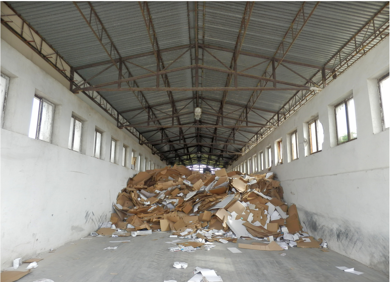
Hala na zhodnocovanie odpadov R12
