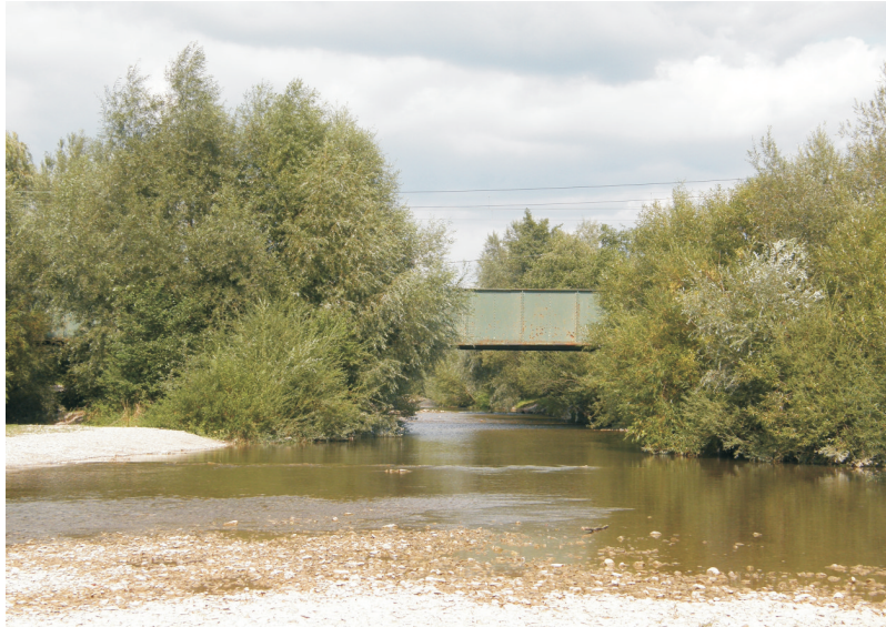
pohľad na most (ľavé pole) od ústia Varínky
