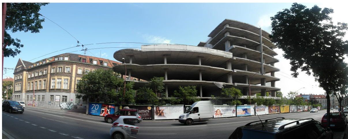
Obr. 13 pohľad na rozostavaný objekt
