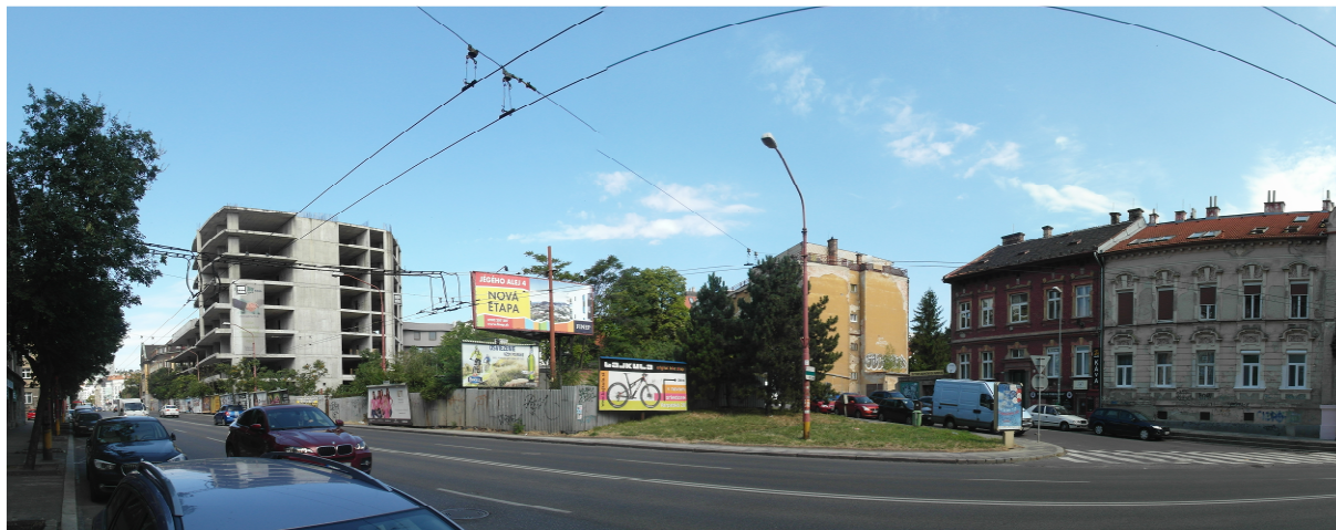
Obr. 12 pohľad na rozostavaný objekt
