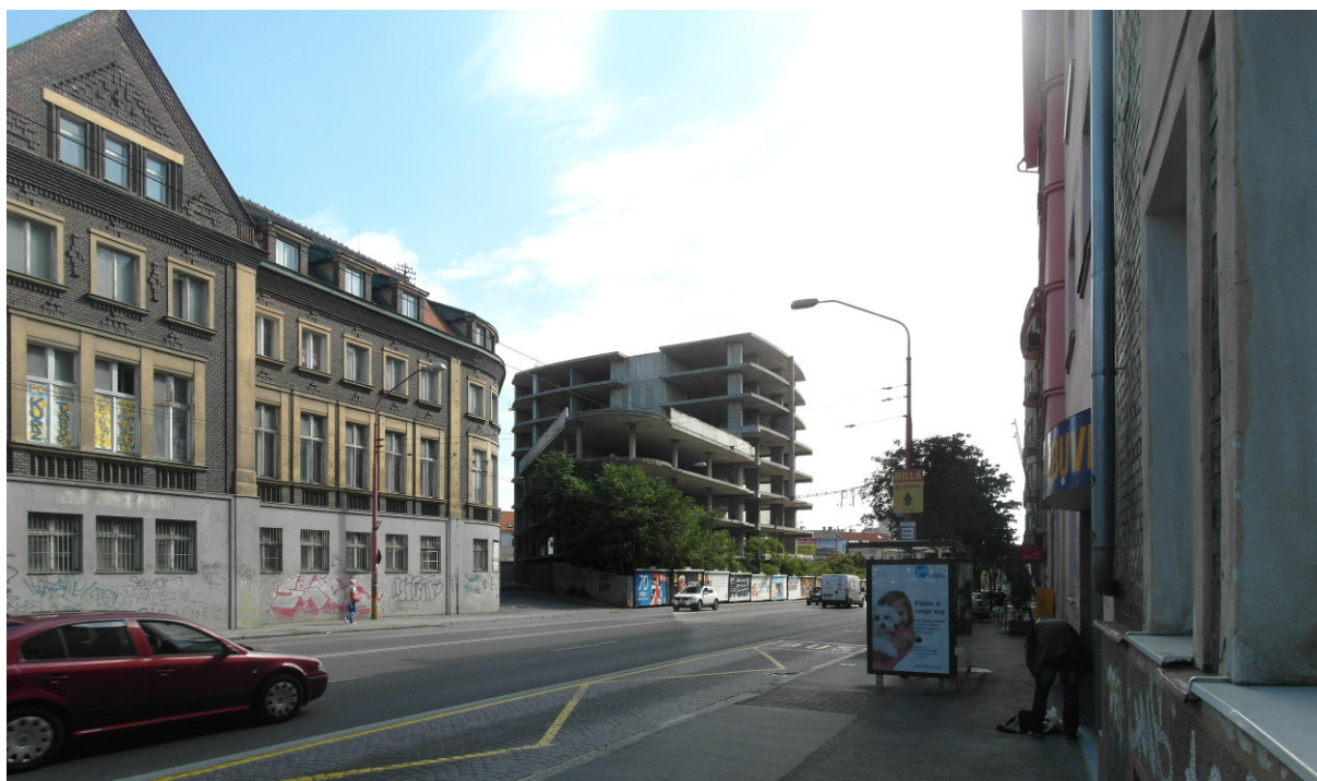
Obr. 14 pohľad na rozostavaný objekt
